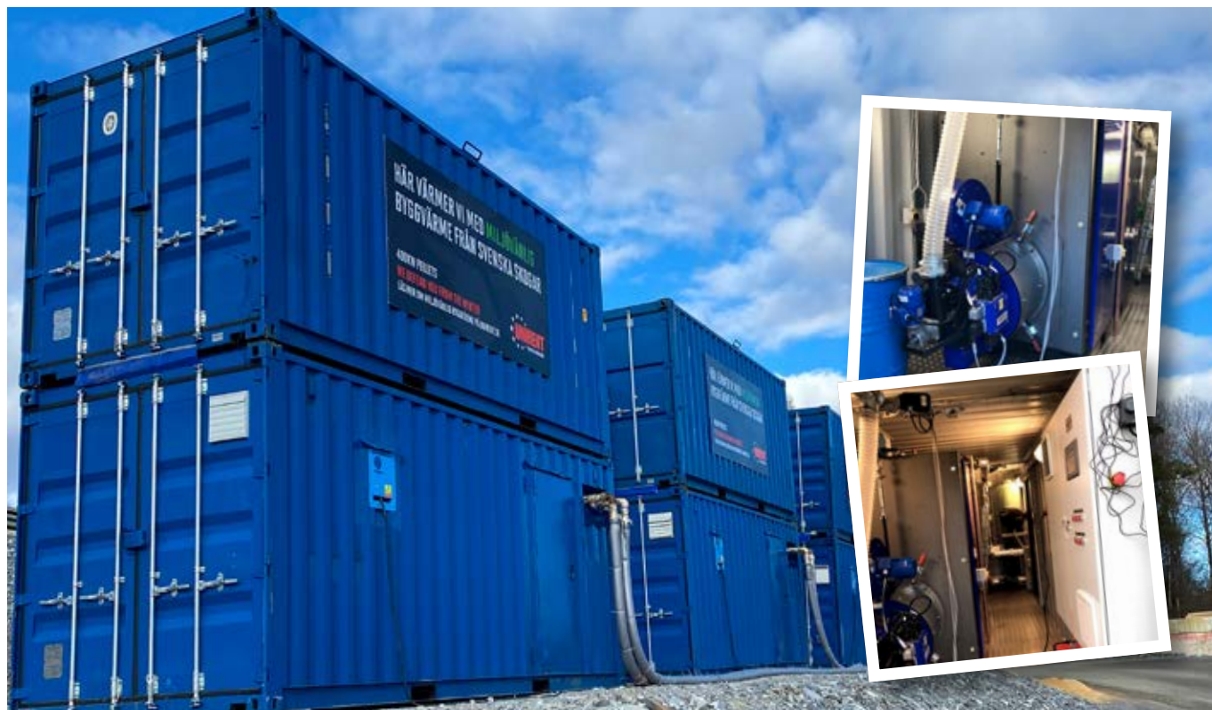
Pelletsanläggningar byggs in containers för kunna placeras ut så smidigt som möjligt. Varje anläggning behöver 2 containers.
