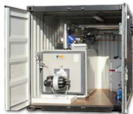
Anslutning och mätinstrument i en mobil panncentral.
